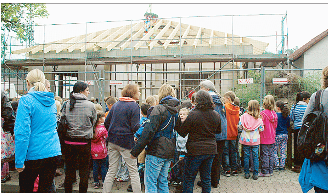
Der im Bau befindliche Anbau wird bestaunt.
